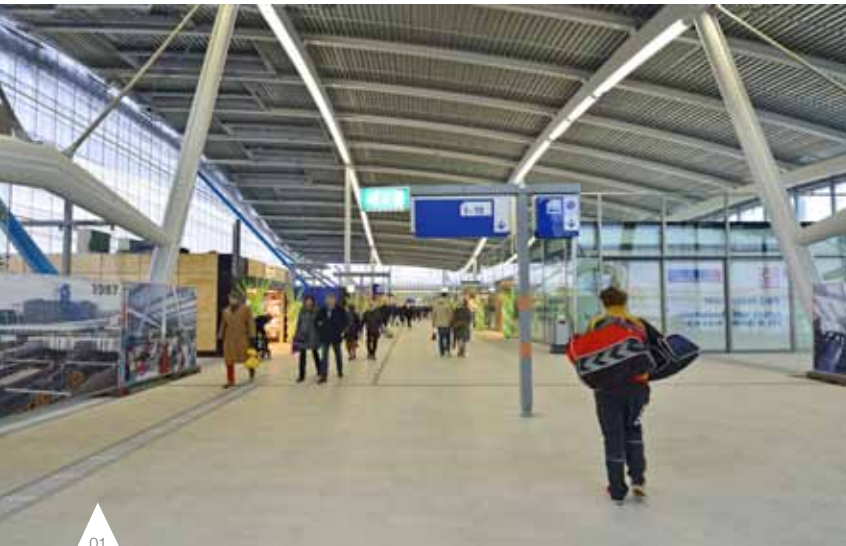
01 OV-Terminal, Utrecht, Nederland Architect: Benthem Crouwel en Movares
