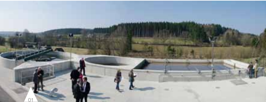
01 Waterzuiveringsstation, Paliseul, België
