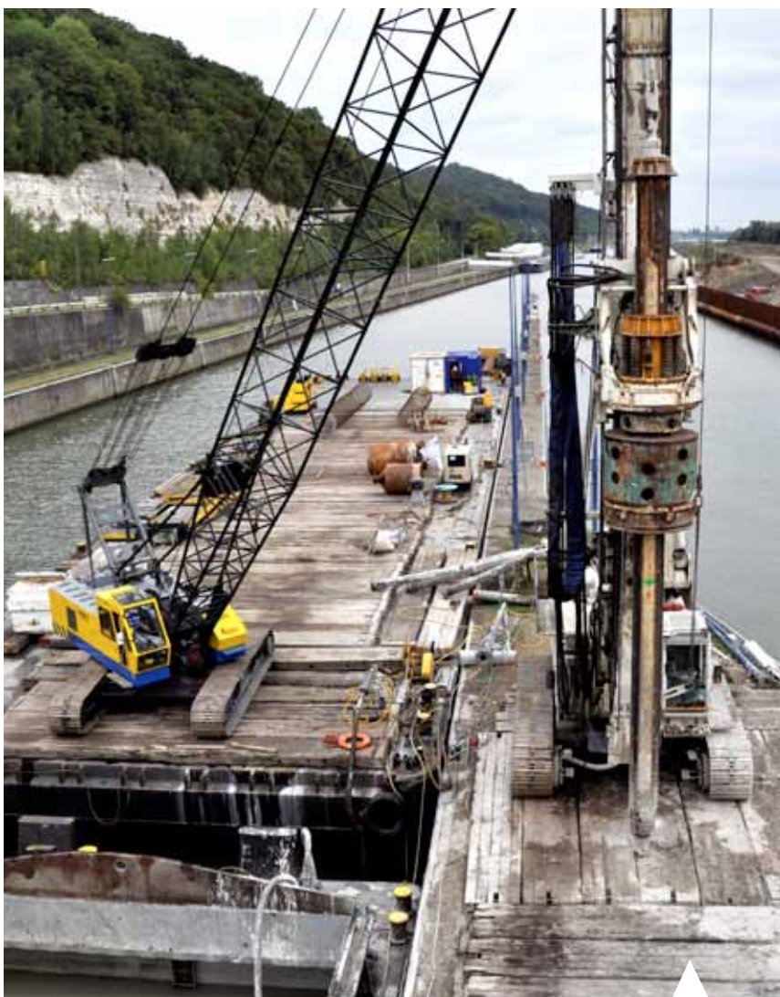
Sluizencomplex, Ternaaien, België
